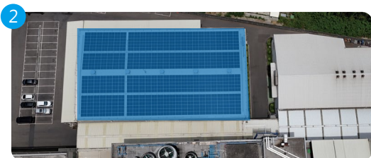
電裝廠 / 材料倉庫屋頂 太陽能板裝置容量：217kW
